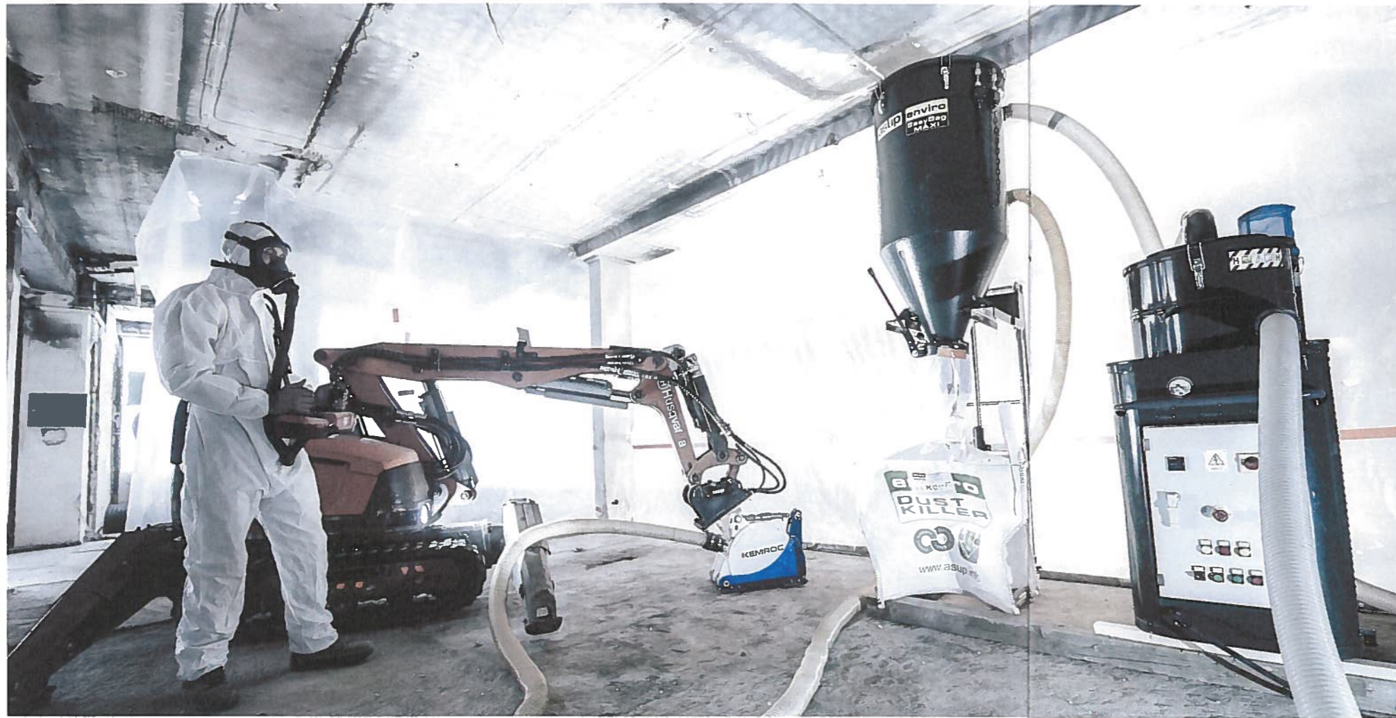
Maschinenkonfiguration [v.l.n.r.] Abbruchroboter-Anbaufräse-Abfüllstation-Saugzentrale im Einsatz
